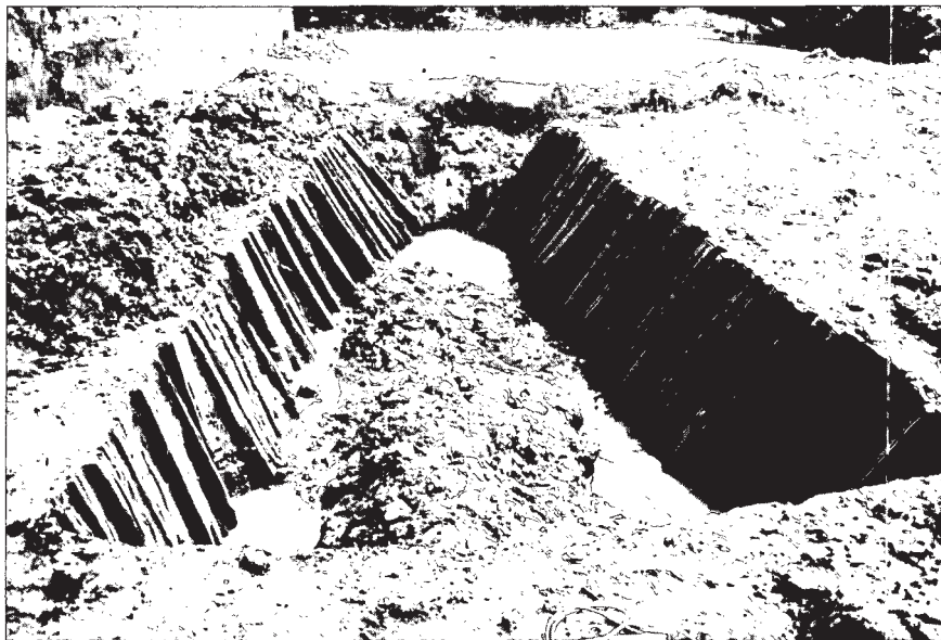
Afb. 5. De gracht- beschoeiing uit de fase Woerden III. Zicht op het oosten.
