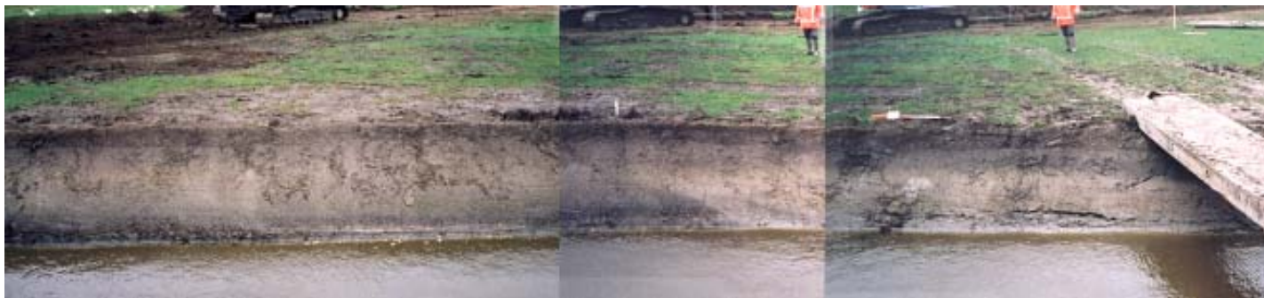
afb. 6 Samengestelde foto van het nieuwe talud (45°) van de sloot, even ten zuidoosten van het onderzoeksterrein.
