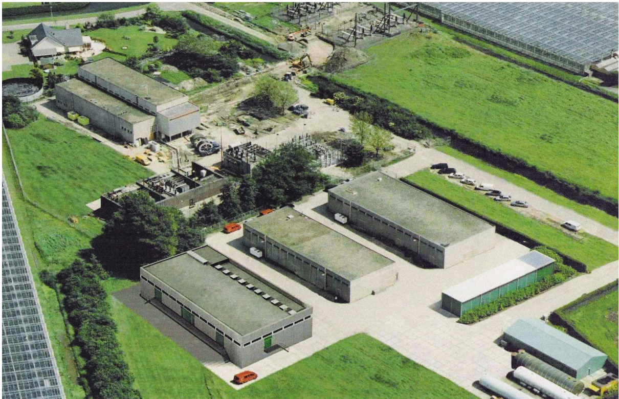
Het plangebied vanuit het westen met een vooruitblik op het derde schakelstation (bron: IOB).
